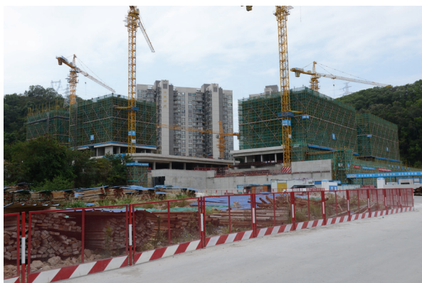
布心項目西北部土地興建情況現場圖 (拍攝於2018年3月6日)
