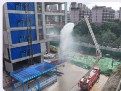
施工區域消防應急疏散演練
